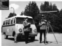
Aparat stereofotograficzny "Wid" do fotografowania miejsc powalonych zdarzeń (1962r.)
